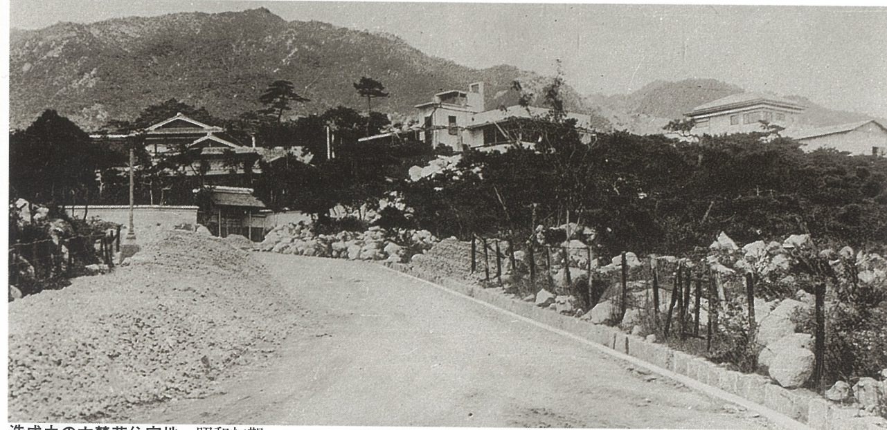
造成中の六麓荘住宅地 昭和初期
