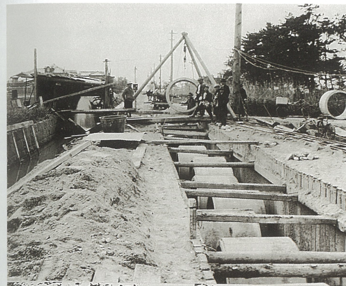
昭和11、12年ごろの下水道埋設工事
