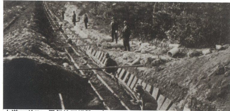
水道、ガス、電気地下埋設工事
