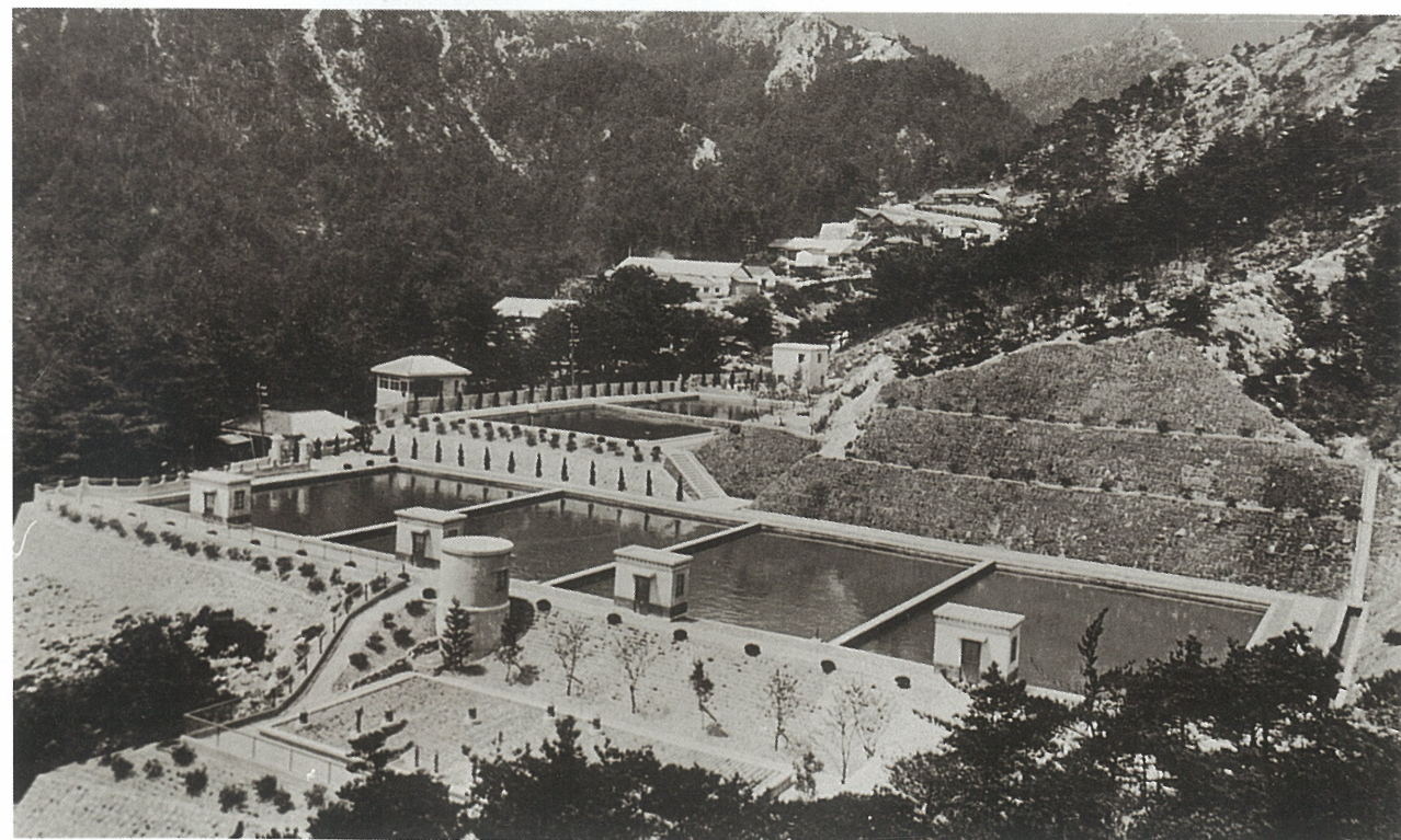
精道村奥山浄水場全景 給水人口5万人、1人1日平均給水量110リットル、給水区域は標高140メートル以上の高所を除く村内一円とされた。昭和13年7月の阪神大水害で大被害をこうむり、全施設の復旧は、17年11月までかかった。
