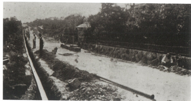
電話地下配線工事
