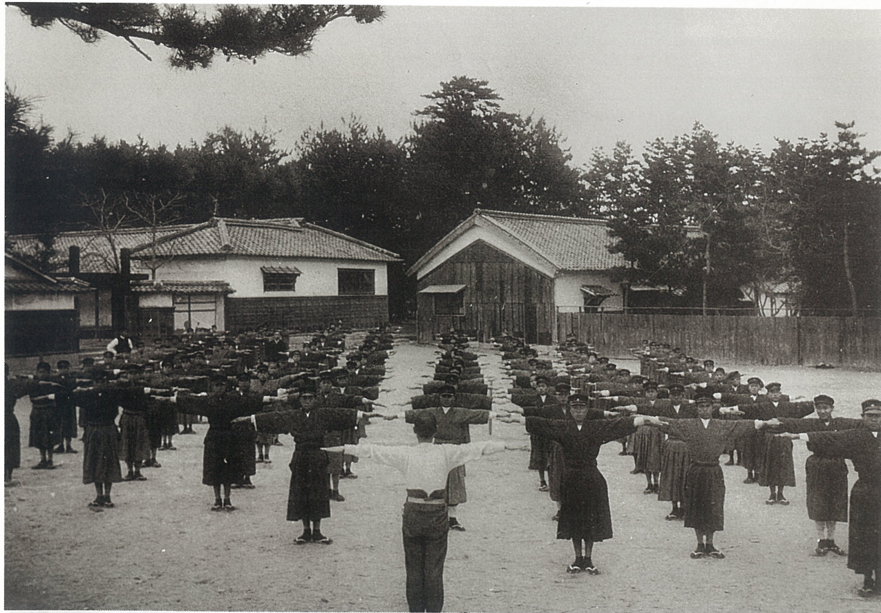
精道小学校内に設置された精道村役場(写真右手の建物) 大正3年ごろ 当時の人口は、5,094人、戸数1,095戸。
