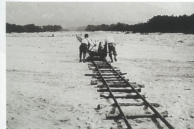
大正初期の芦屋川改修工事風景 この写真からも、芦屋川の川幅の広さがうかがえる。
