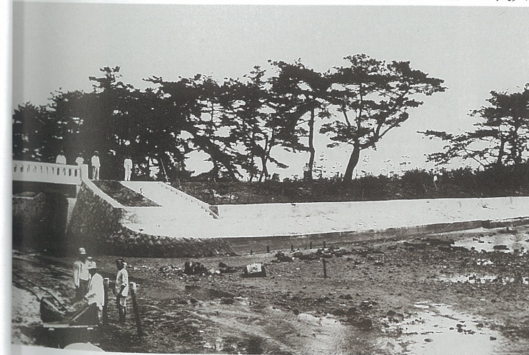
防潮堤ができた当時の宮川河口 昭和12年ごろ 左は潮風橋。
