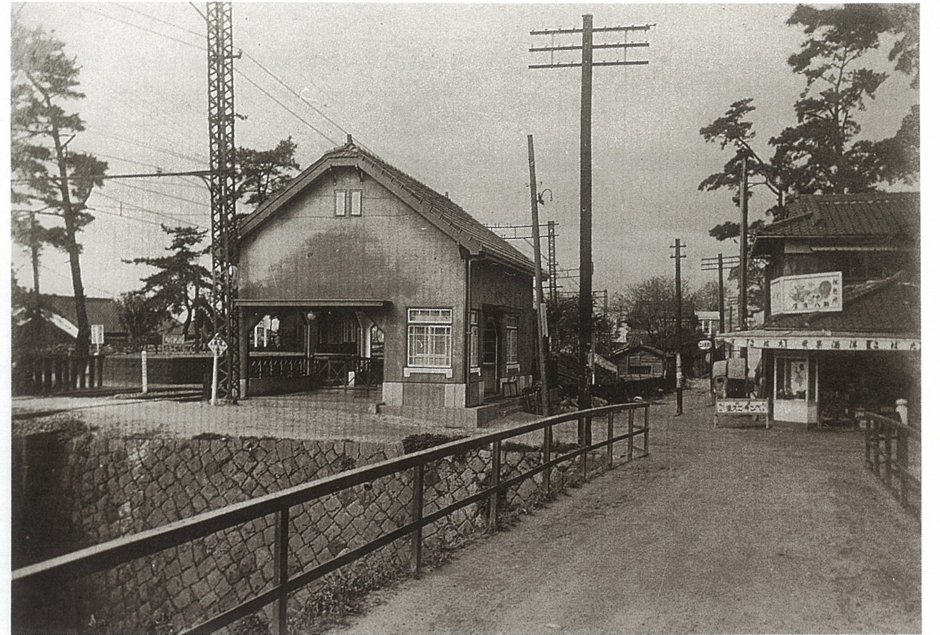
阪急芦屋川停留所 この付近は、谷崎潤一郎の小説『細雪』の舞台となったところ(昭和初期)。
