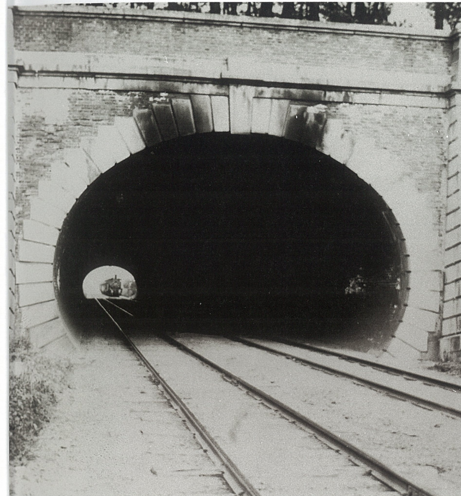
芦屋川トンネル(天井川風景)
