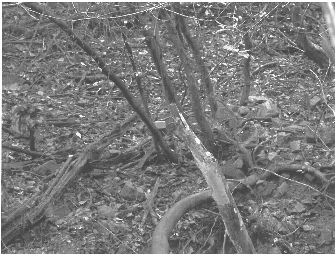
堰堤下流側 杭 (堰堤南側讓渡部分)
