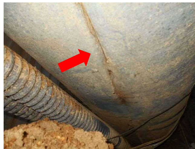
【輸送管の交換工事状況①】 約31mの直管を約6mごとに分割して順番に接続してした。
