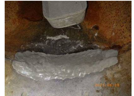
水中ボンド充填 補修完了
