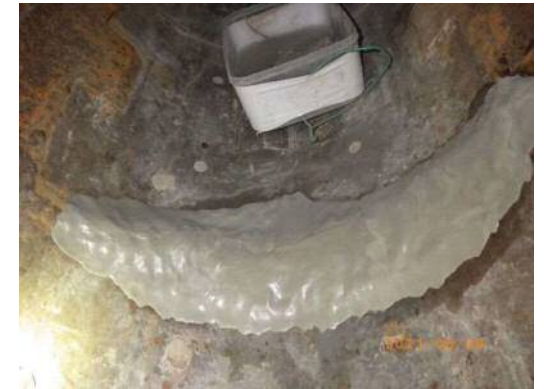
水中ボンド充填 補修完了
