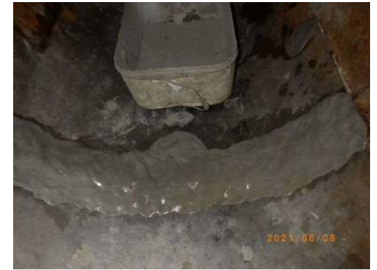
水中ボンド充填 補修完了
