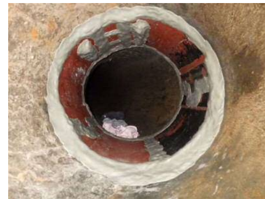
水中ボンド充填 補修完了
