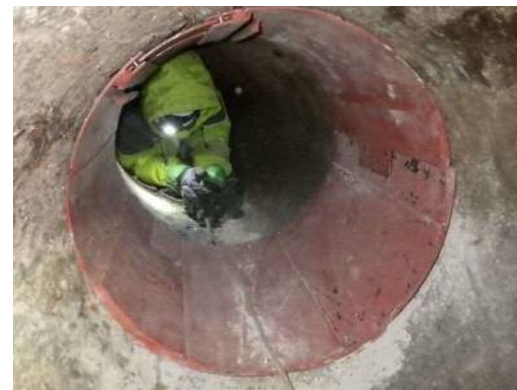
鋼板製内貼補修材設置
