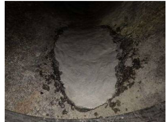
水中ボンド充填 補修完了
