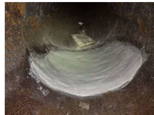
水中ボンド充填 補修完了
