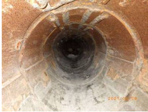
施工後の侵入水確認 (3箇所施工後)
