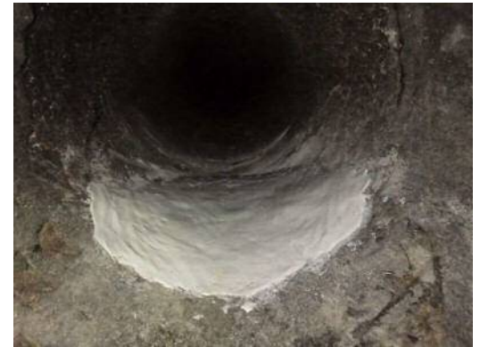
水中ボンド充填 補修完了
