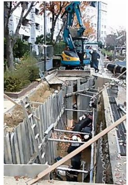
輸送管の交換作業
