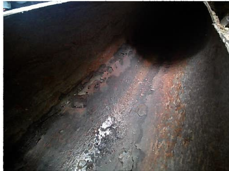
輸送管内の亀裂（輸送管開口部から）
