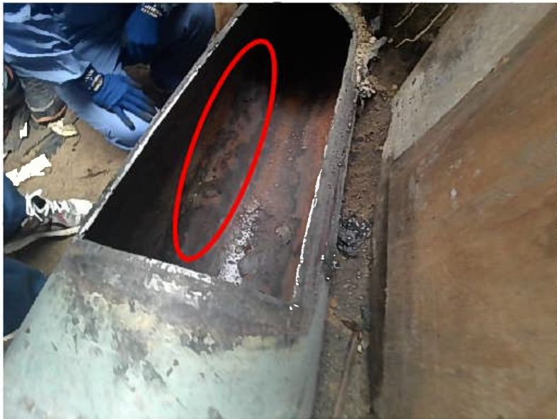
輸送管内の亀裂（輸送管開口部から）
