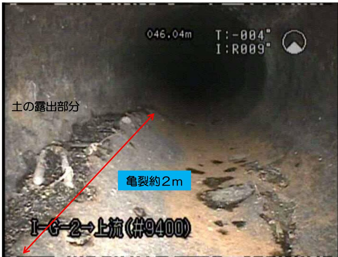
輸送管内の亀裂（約2m）
