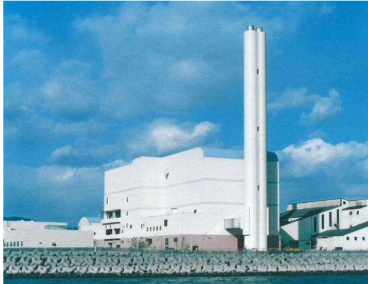
図 2-11 ごみ焼却施設（4 代目，現在稼働中）
