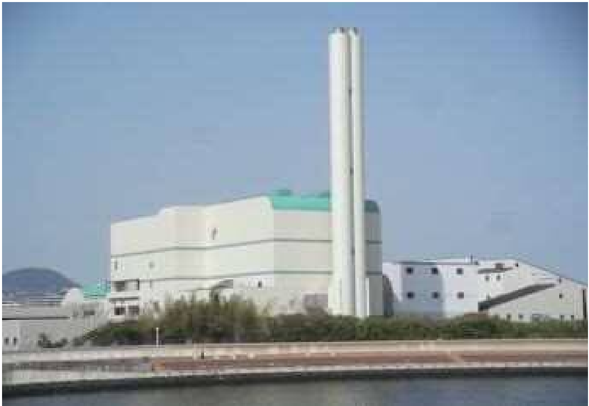
芦屋市環境処理センター
