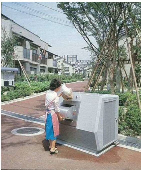
地区投入施設（地上投入口）
