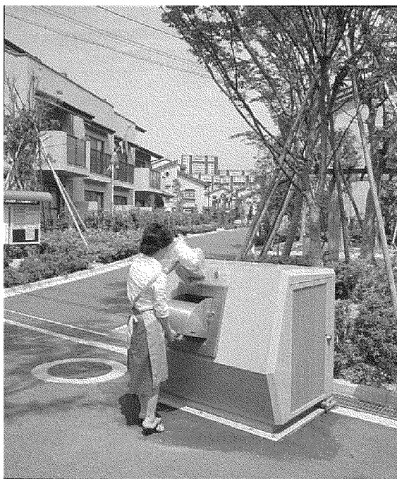
地区投入施設（地上投入口）
