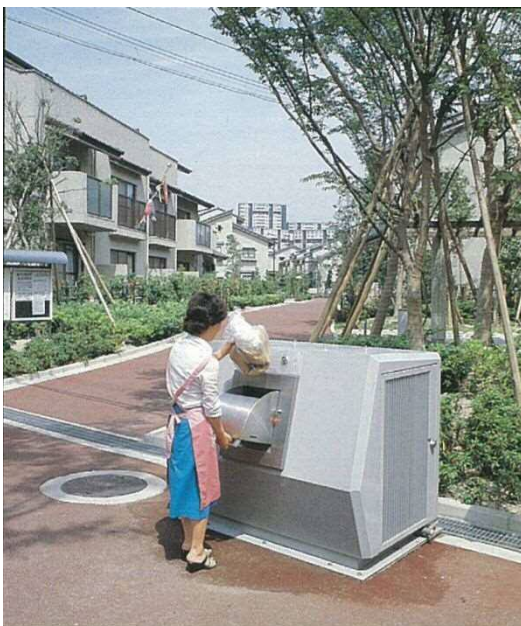
地区投入施設（地上投入口）
