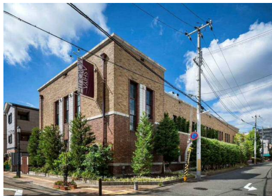
旧芦屋郵便局電話事務室（外観）
