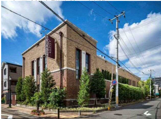
旧芦屋郵便局電話事務室（外観）
