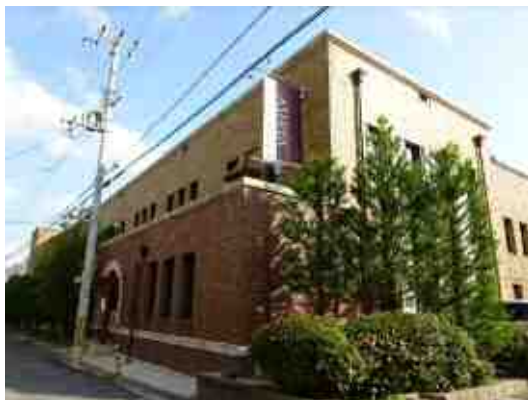
旧芦屋郵便局電話事務室 外観
