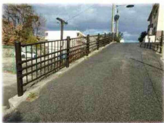
防護柵 (改修後)
