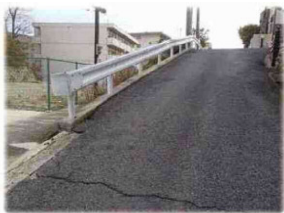
防護柵 (改修前)
