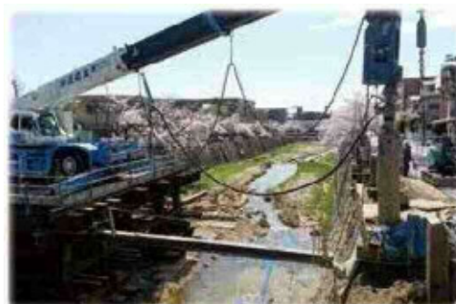
架け替え工事中の開森橋
