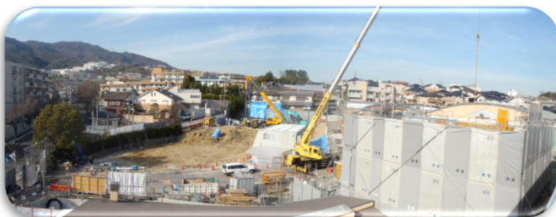
〔岩園幼稚園の工事〕
