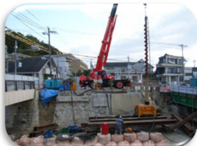
〔開森橋の工事〕
