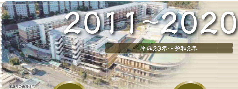
高浜町の市営住宅
