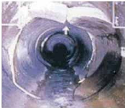
下水道管内の状況
