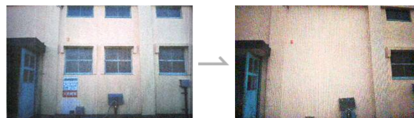
ポンプ場の耐震化
