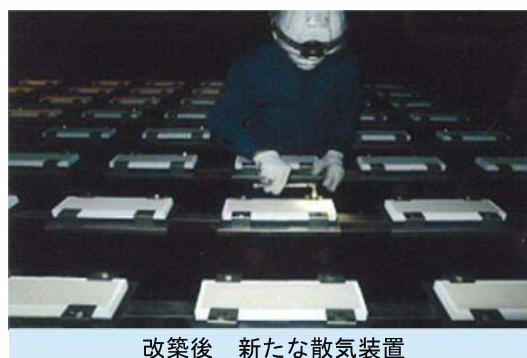
写真 8 機械設備の改築状況
