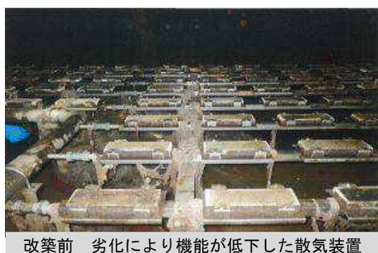
写真 8 機械設備の改築状況
