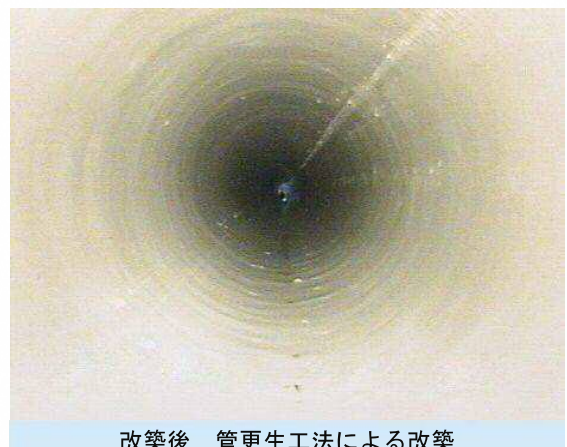
改築後 管更生工法による改築
