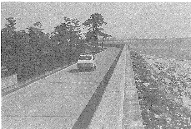
図342 芦屋海岸の防潮堤（西方から東方を望む）
