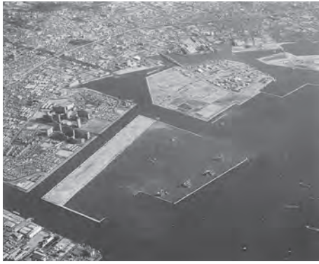
49 工事中の南芦屋浜
