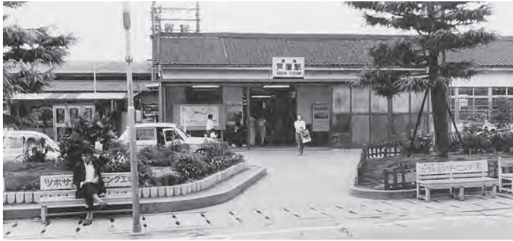
2-13 駅前広場整備前の国鉄芦屋駅
