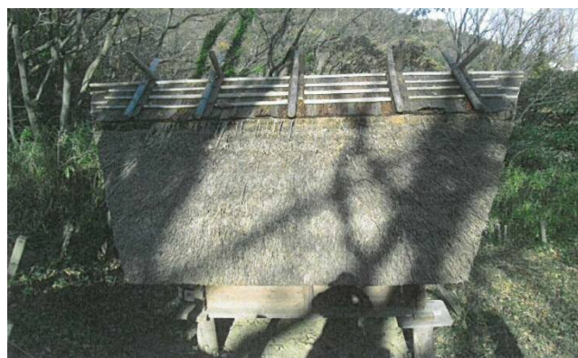
高床倉庫屋根千木の修復状況
