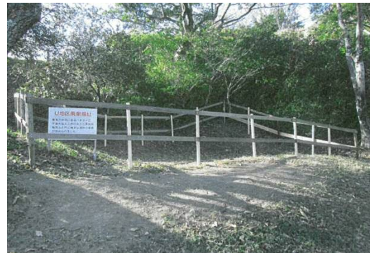
U 地区柵復旧状況
