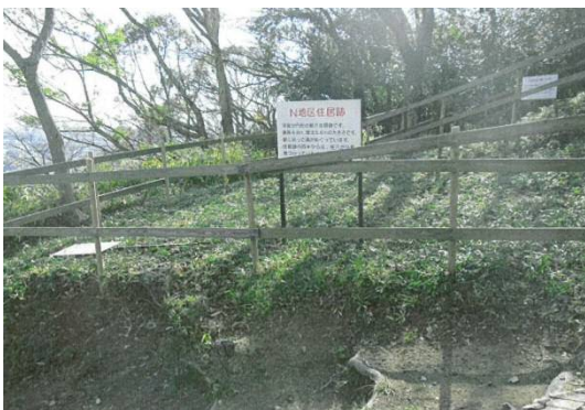
N 地区柵・説明板復旧状況
