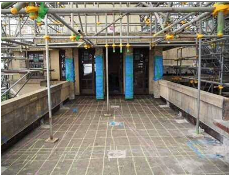
3 4階テラス 防水材撤去後
