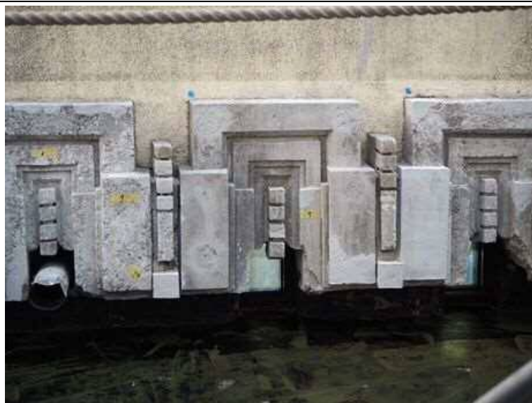
2 屋根 擬石飾り石 修理状況
