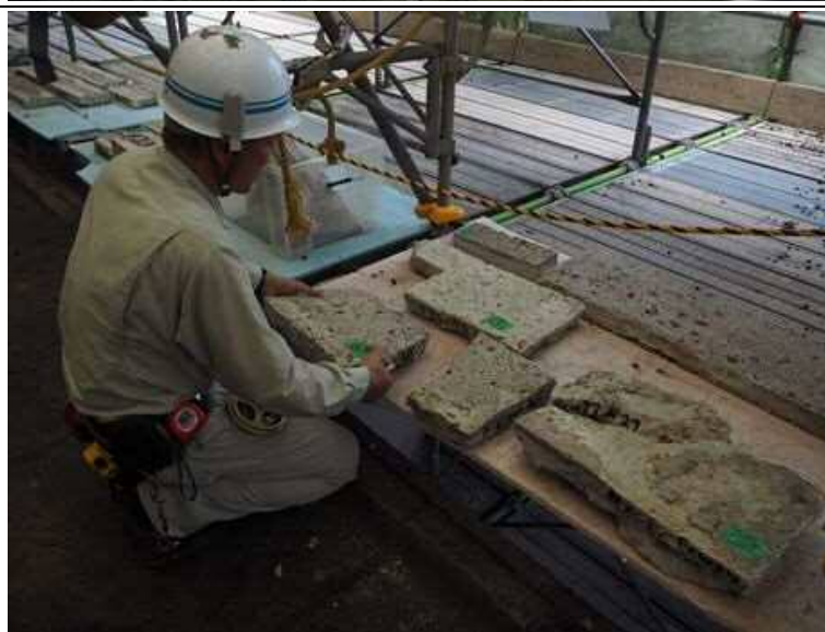
3 バルコニー大谷石 取り外し状況
