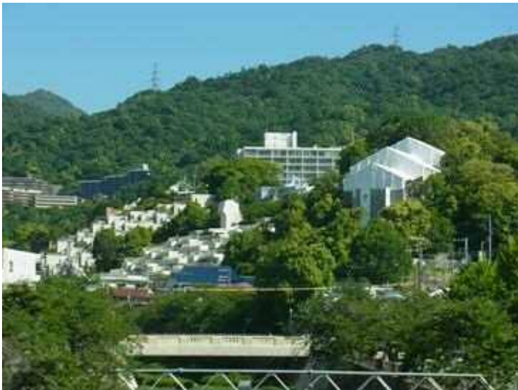
2 工事素屋根設置状況
