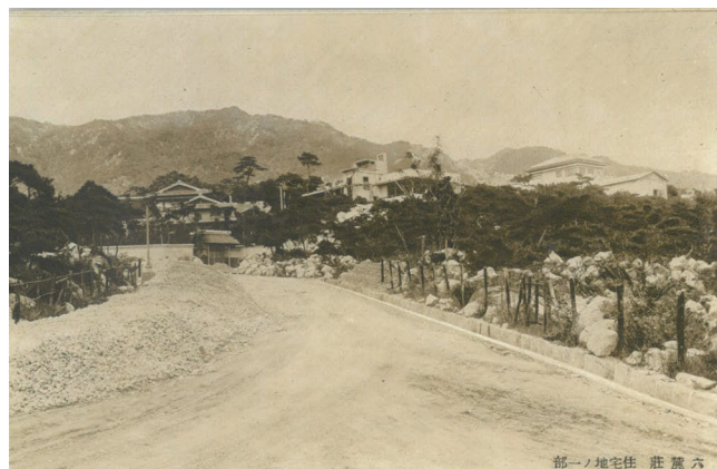
造成中の六麓荘住宅地
