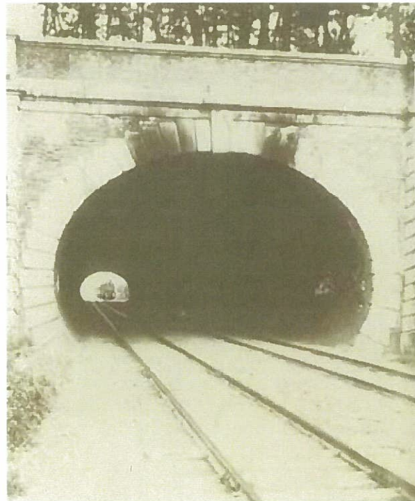
芦屋川隧道（明治7年〔1874〕開通）
