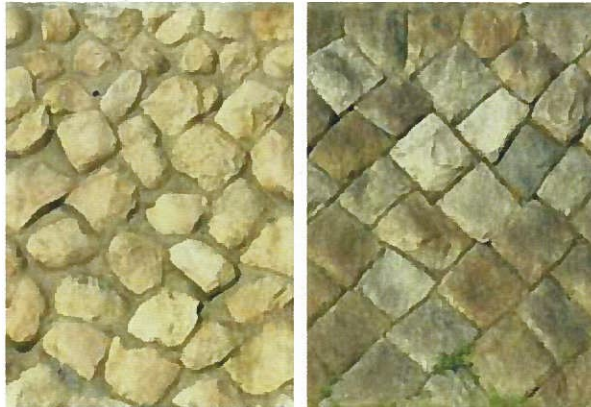
芦屋川の護岸（左：野面積み 右：谷積み）
