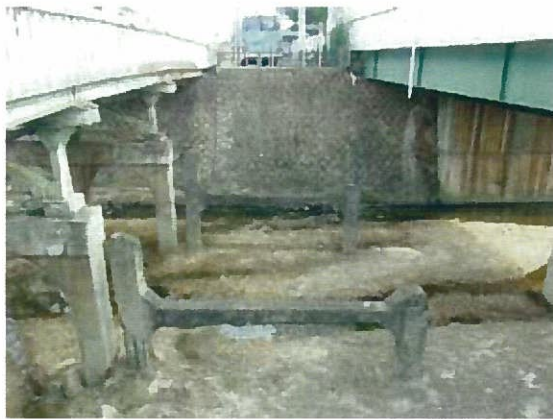
初代桜橋の橋脚
