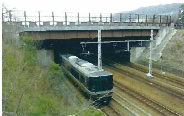
官設鉄道芦屋川隧道跡 (現・JR東海道本線芦屋川跨線水路橋)
