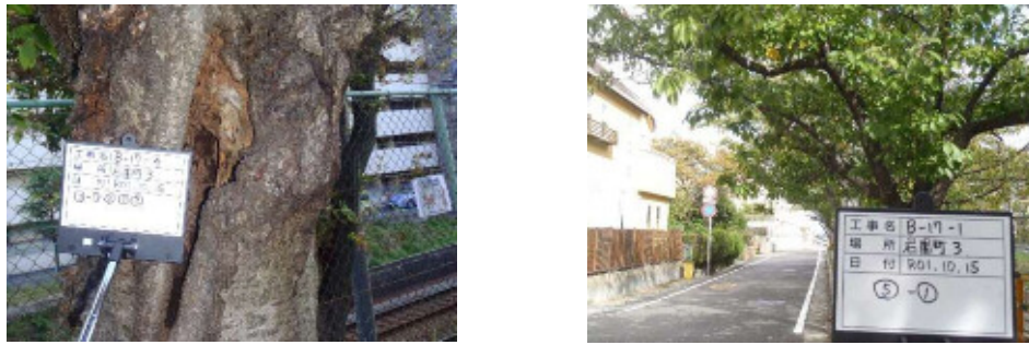
図 3-7 サクラの腐朽や建築限界侵害
