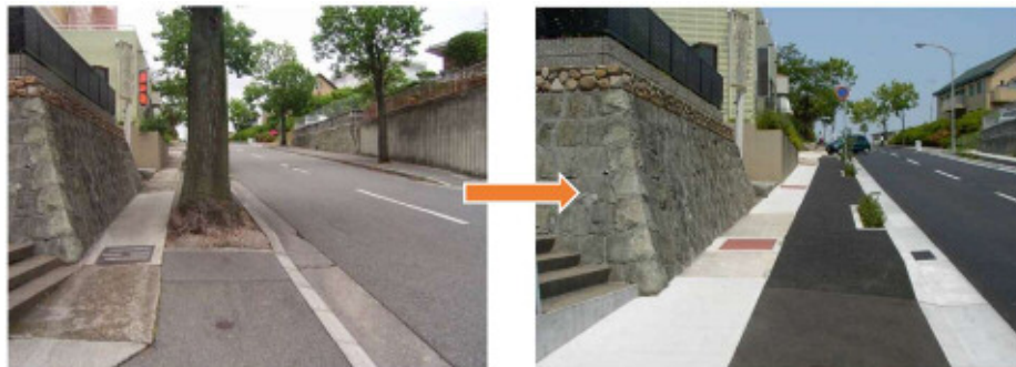
図 3-8 歩行空間が確保されていない歩道の歩行者空間確保例 [神戸市街路樹再整備方針より]
