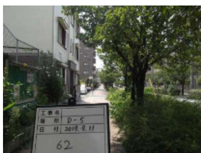
建築限界の侵害（歩道側）
