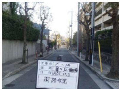
歩行空間が確保されていない歩道
