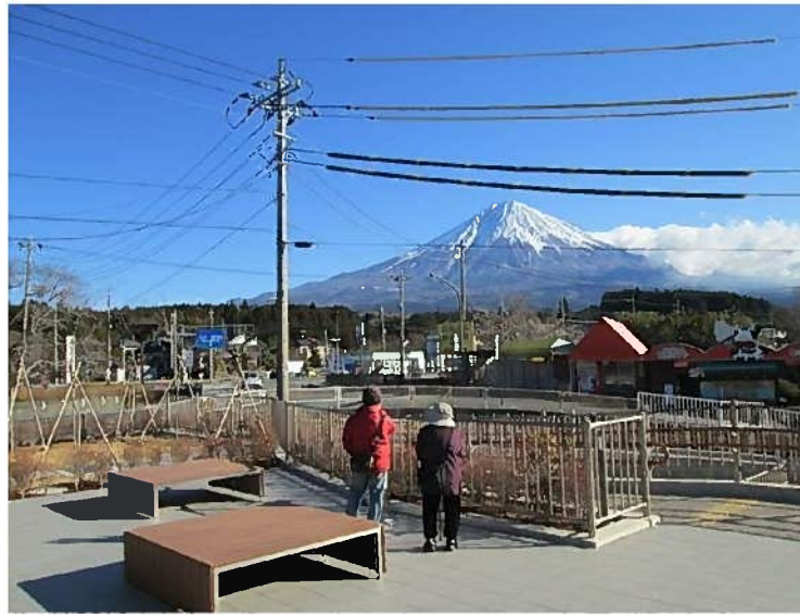
【静岡県富士宮市】 迫力のある富士山を電柱と電線が邪魔をしている。
