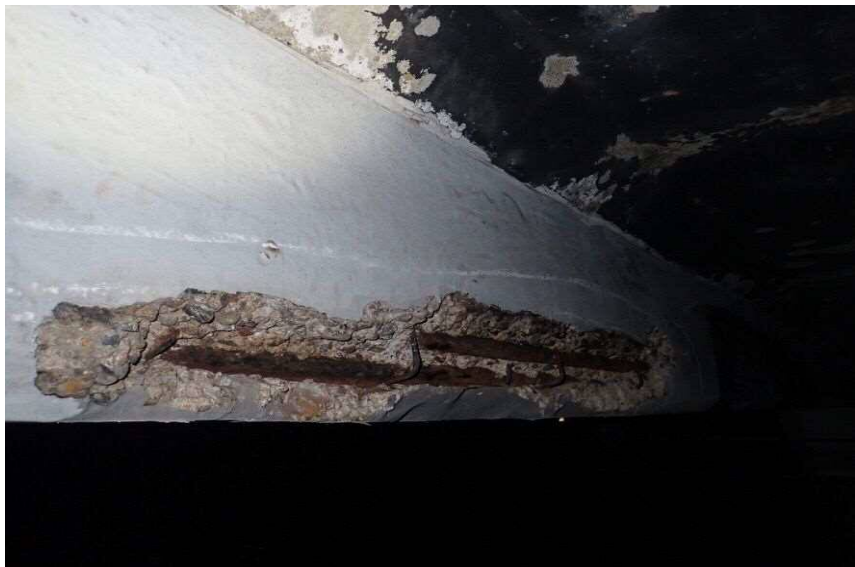
下部構造（橋脚）鉄筋露出
