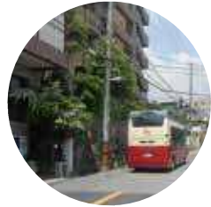
通行の邪魔になっている電柱の様子
