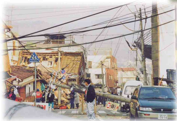
地震で倒壊し、道路を塞ぐ電柱（津知町）
