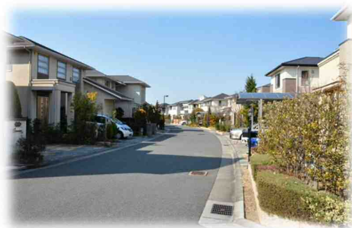
南芦屋浜地区のまちなみ（南浜町）
