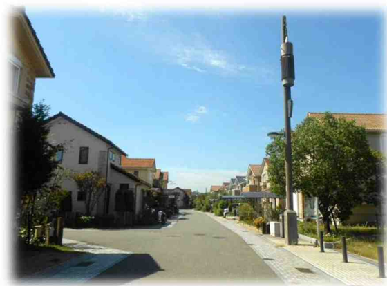
柱状型機器（海洋町）
