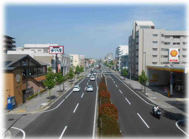
緊急輸送道路（国道2号）
