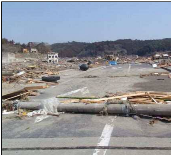
道路の 防災性能の向上
