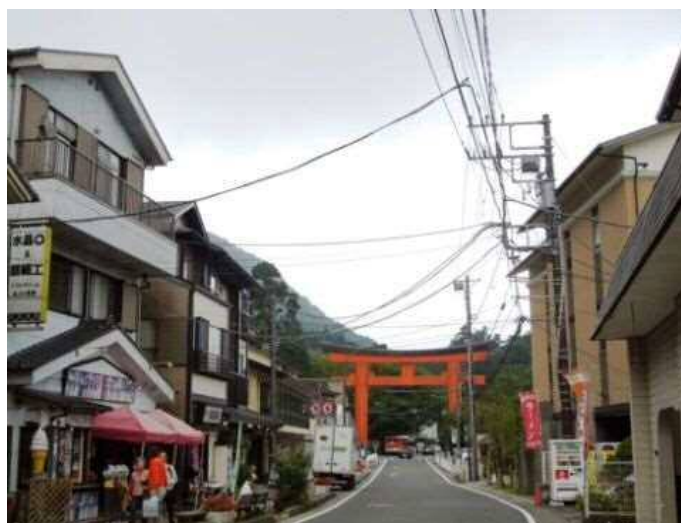
【神奈川県足柄下郡箱根町】 参道に張り巡らされる電線。
