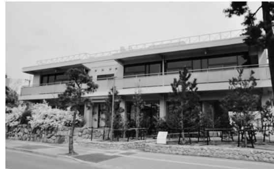
新しいセンター(公光分庁舎・北館)
