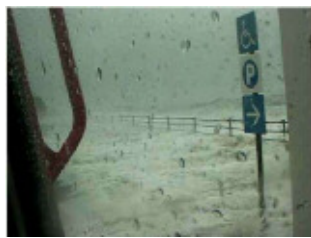
写真2. 南護岸からの越波状況
